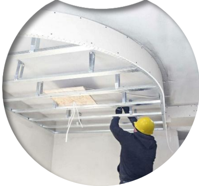
Установка натяжных или подвесных потолков
