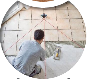
Укладка напольного покрытия
