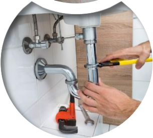
Монтаж/замена санитарно-технических элементов
