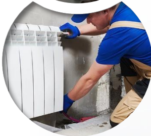
Монтаж/замена элементов отопления
